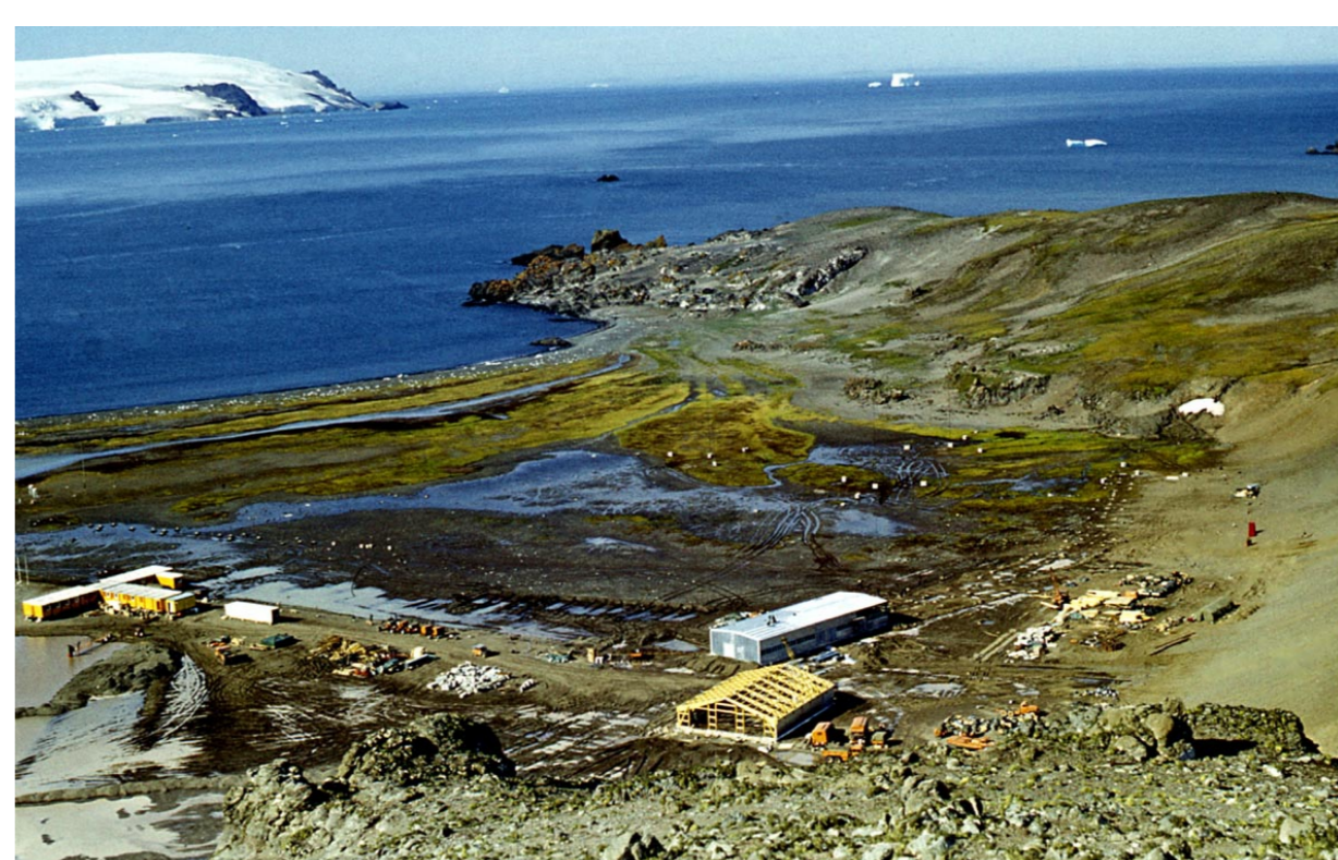
Budowa Stacji Arctowskiego
